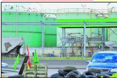
L'entrée de l'usine de Grand Couronne était barricadée
